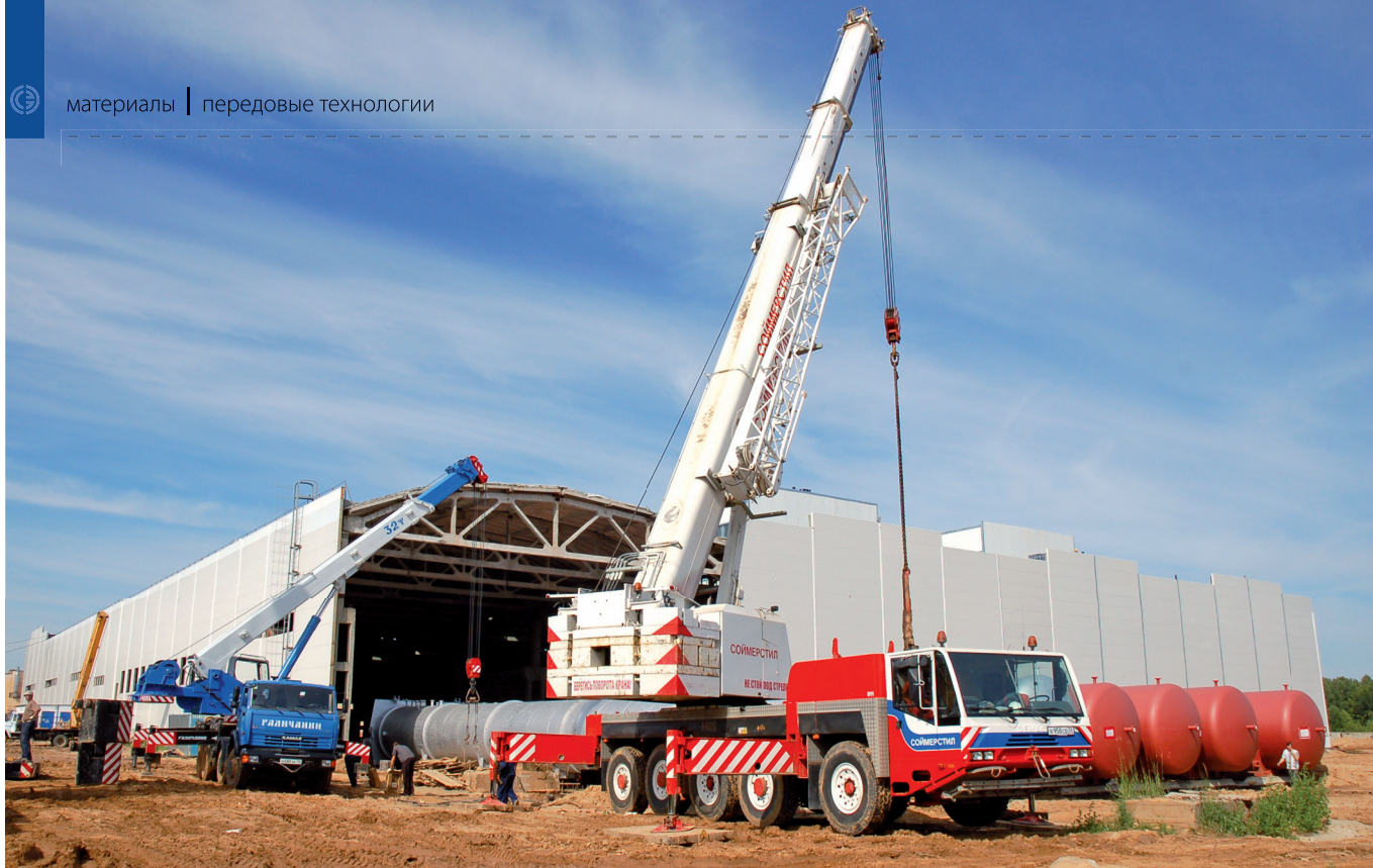
Монтаж уникальных автоклавов длиной 44 метра и диаметром 3,5 м
